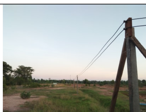
โดยการติดตั้งเสาไฟและ เดินสายไฟ
