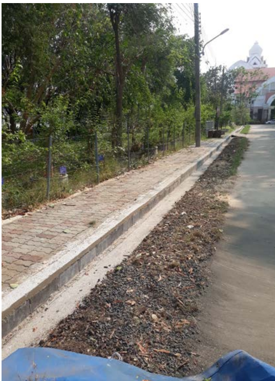
ภาพที่ 3 : ภาพแสดงการปรับปรุงถนนทางเดิน
