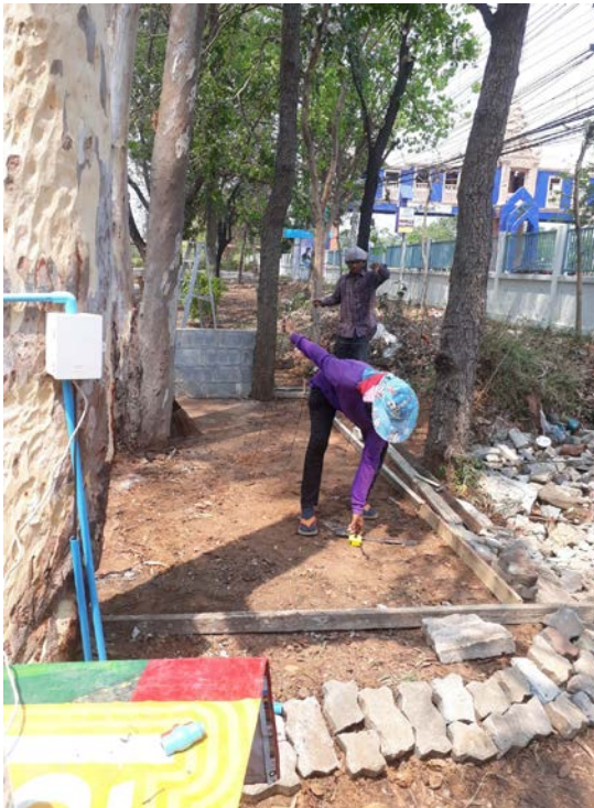
ภาพที่ 24 : แสดงการปรับปรุงระบบน้ำ
