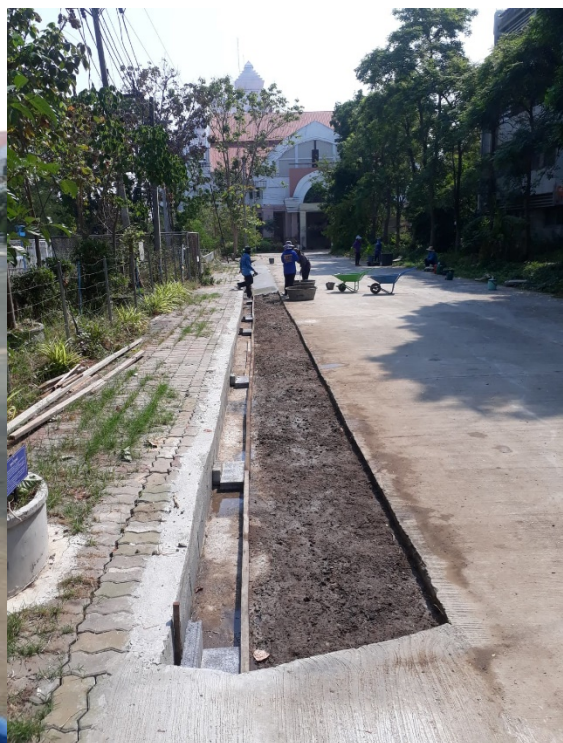
ภาพที่ 4 : ภาพแสดงการปรับปรุงถนนทางเดิน
