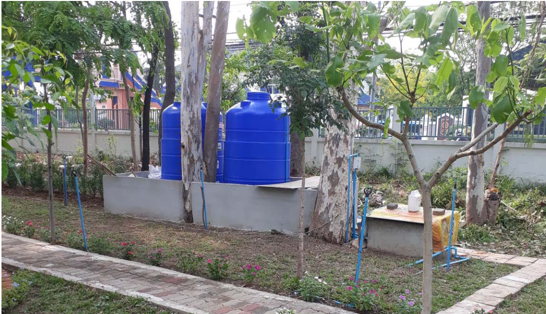
ภาพที่ 26 : แสดงการปรับปรุงระบบน้ำ
