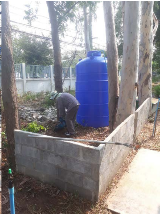
ภาพที่ 25 : แสดงการปรับปรุงระบบน้ำ
