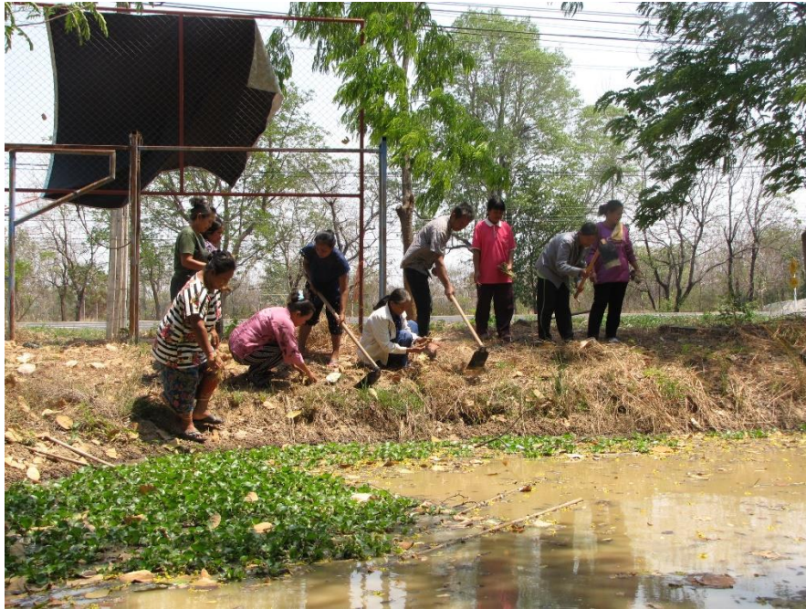
ภาคบ่ายฝึกปฏิบัติการทำแปลงขยายพันธุ์หญ้าแฝกและการปลูกหญ้าแฝกตามแนวขอบสระ เพื่อใช้ประโยชน์ในการพังทลายของดิน
