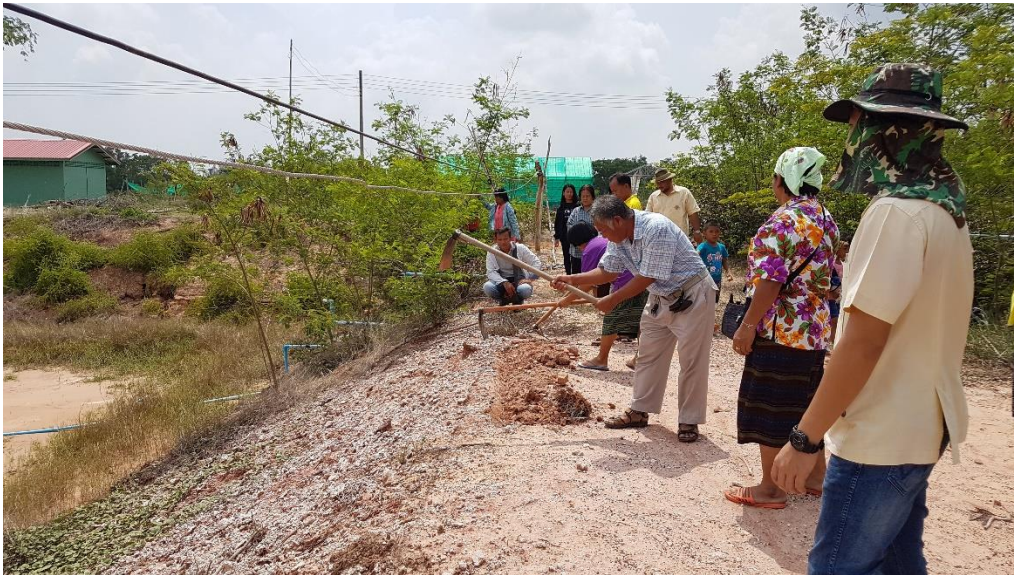
ผู้เข้าอบรมฝึกปฏิบัติการปลูกหญ้าแฝกตามแนวอ่างเก็บน้ำเพื่อป้องกันการเซาะและยึดหน้าดิน
